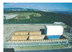
極低レベル廃棄物の処分施設
