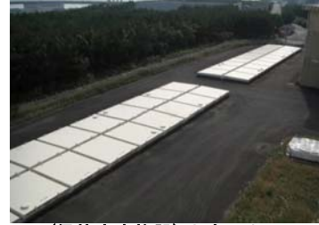
(保管廃棄施設)上空より
